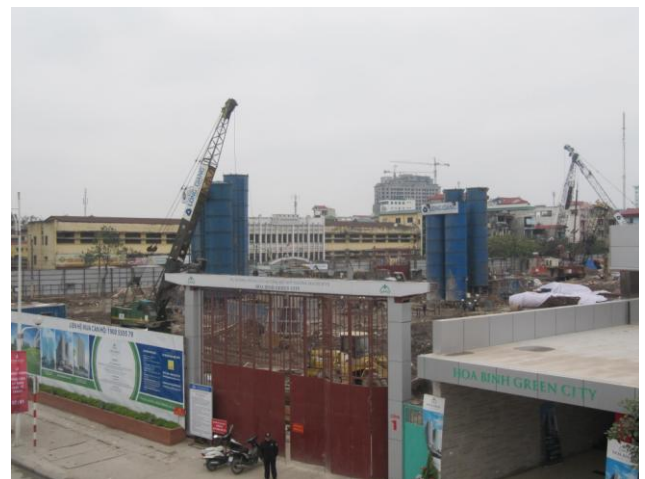
Hòa Bình Green City đang xây móng
