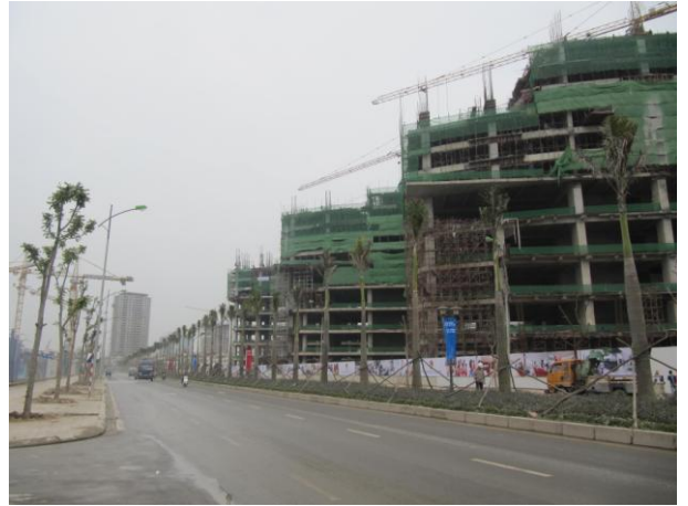
Văn Phú Victoria thi công đến tầng 8
