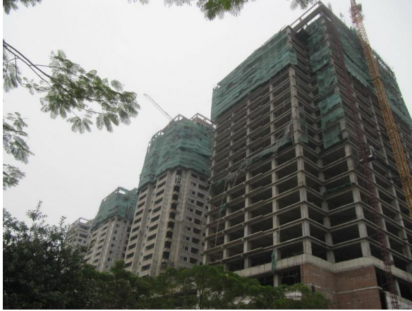
Hapulico Complex thi công xong thô
