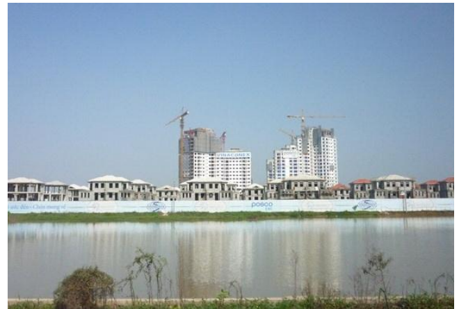
Khu đô thị Splendora đang hoàn thiện biệt thự và chung cư giai đoạn 1
