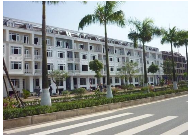
Geleximco đang hoàn thiện liên kề
