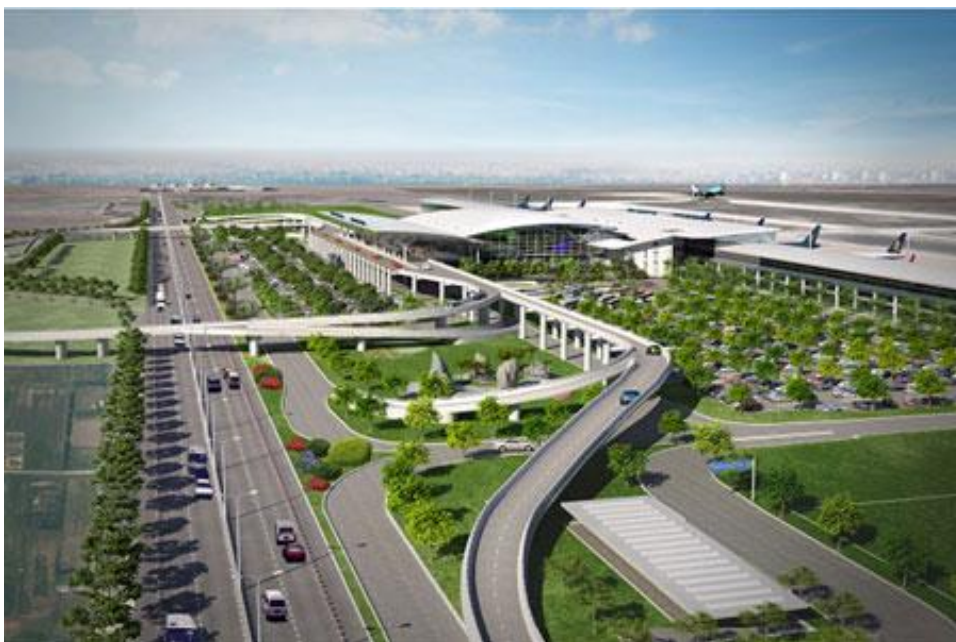
Nhà ga T2 sân bay Nội Bài vừa được khởi công xây dựng, dự kiến hoàn thành cuối năm 2014
