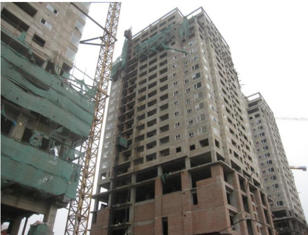
Hapulico Complex đã hoàn thiện xây thô
